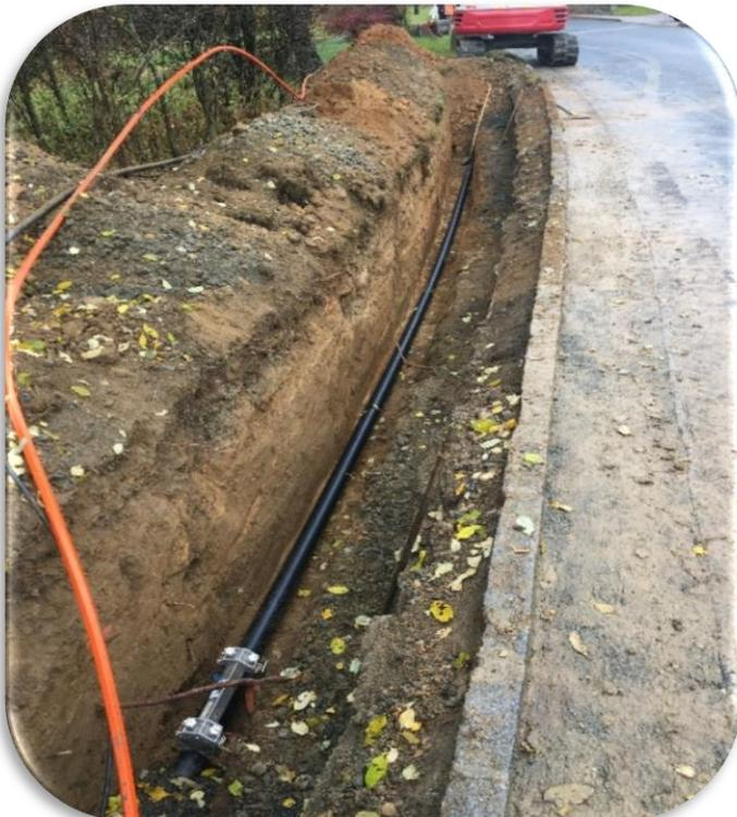
Die Sanierungsarbeiten der Wasserleitung Bergwerk – 1. Bauabschnitt sind voll im Gange. Im Zuge der Sanierung wird von der Firma Kabelplus auch das Glasfaserinternet mitverlegt und durch die Energie Burgenland erfolgt gleichzeitig die Verkabelung der Stromversorgung.
